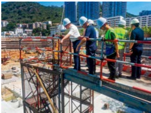
李东在国际学校项目现场
